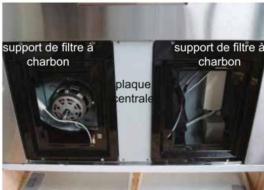
2. En utilisant les éléments du ZRC-0200, installez (2) supports de filtre à charbon et la plaque centrale au bas de la hotte à l'aide de (4) vis pour chaque élément. Les vis sont préinstallées. Enlevez-les avant d'installer les supports et la plaque centrale. Remettez les vis en place.
