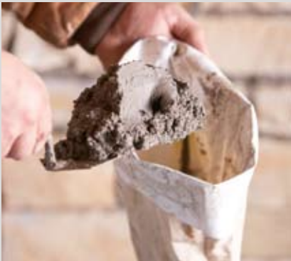
Fill grout bag
