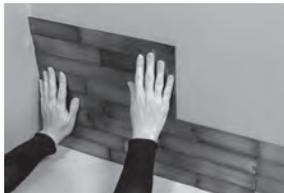
Lorsque vous placez la deuxième rangée de tuiles et les suivantes, positionnez la tuile à angle de 30 degrés vers vous et posez la bordure inférieure sur la tuile en dessous, puis faites-la glisser pour buter la tuile précédente.
