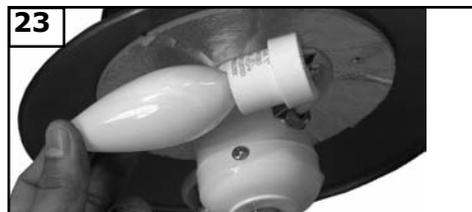
Installez les ampoules basses de candélabres de 2x60 watts. Ampoules incluses. **AVERTISSEMENT: les lumières du ventilateur ne s'allumeront pas avec des ampoules au wattage supérieur à celui nécessaire. Déconnecter les lumières en éteignant l'interrupteur, le disjoncteur, ou par télécommande le cas échéant. Remplacer les ampoules par de nouvelles au wattage adéquat, puis ouvrir le courant.**
