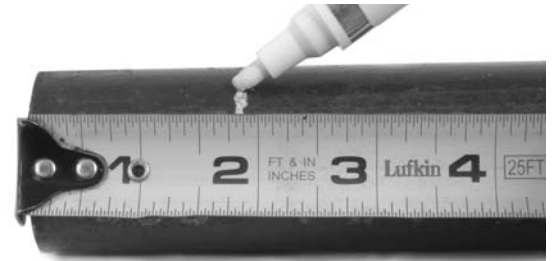
Figure 6A – Repérage de la profondeur d'insertion du tuyau à l'aide d'un mètre à ruban
