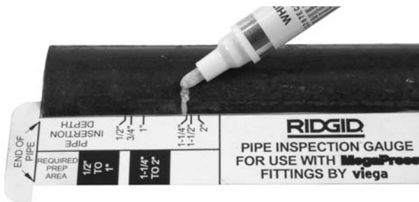
Figura 6B – Valiéndose de un calibre MegaPress® de RIDGID®, marque hasta dónde debe insertarse el tubo dentro del acoplador
