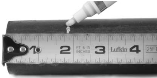
Figura 6A – Valiéndose de una cinta métrica, marque la profundidad hasta donde debe insertarse el tubo dentro del acoplador
