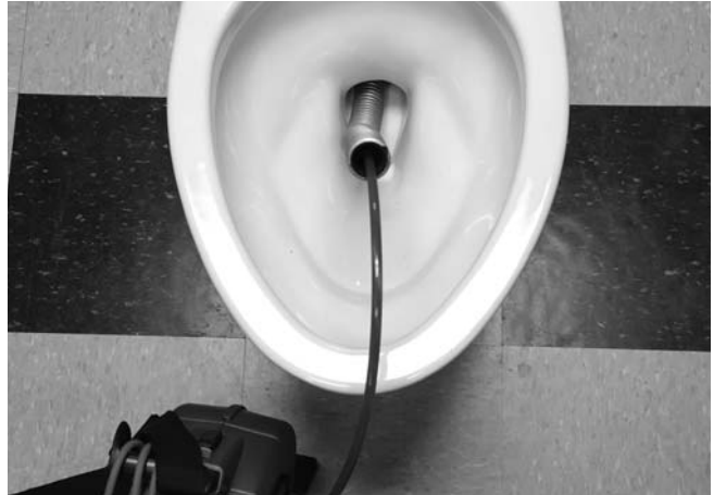
Figure 25 – Utilisation d'un guide flexible
