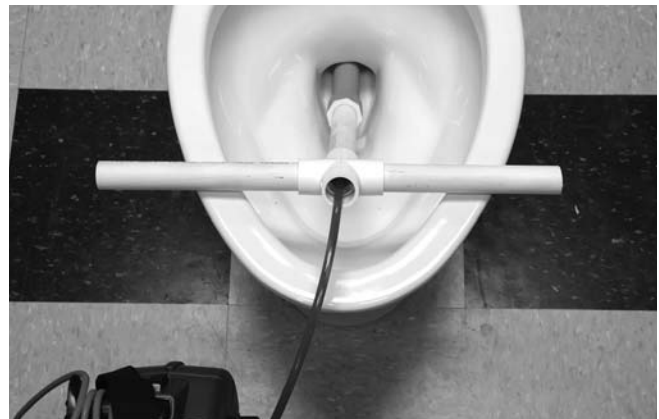
Figura 24 – Empleo de un tubo-guía de PVC
