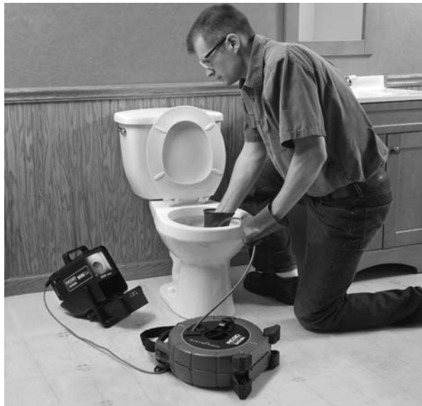
Figure 15 – Inspection en cours
