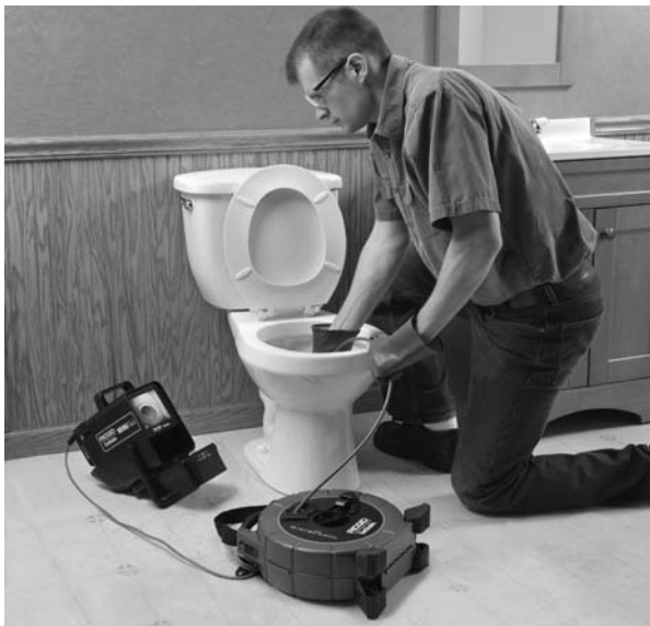
Figura 15 – Una inspección en marcha
